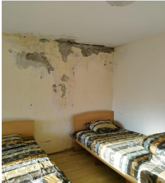
Снимки: екип на омбудсмана, август 2022
