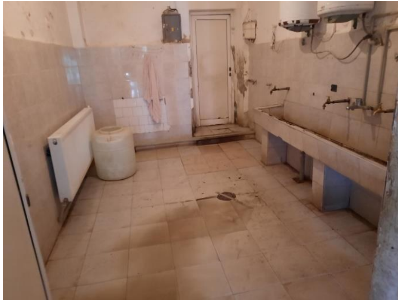
Снимки: екип на омбудсмана, август 2022
