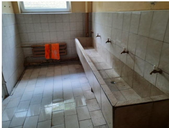
Снимки: екип на омбудсмана, август 2022
